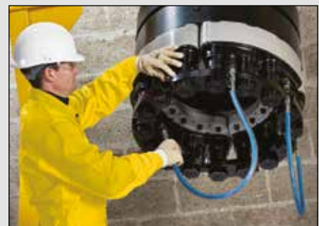
▲ Aplicación de tensionado multiespárrago.
